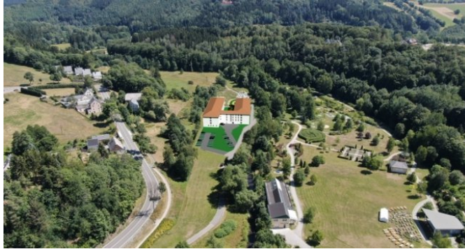
Die Einrichtung entsteht in direkter Nähe zur B 101. Im Bild rechts ist der Kurpark zu sehen, links verläuft die Bundesstraße. Foto: Theed Projekt Gruppe
